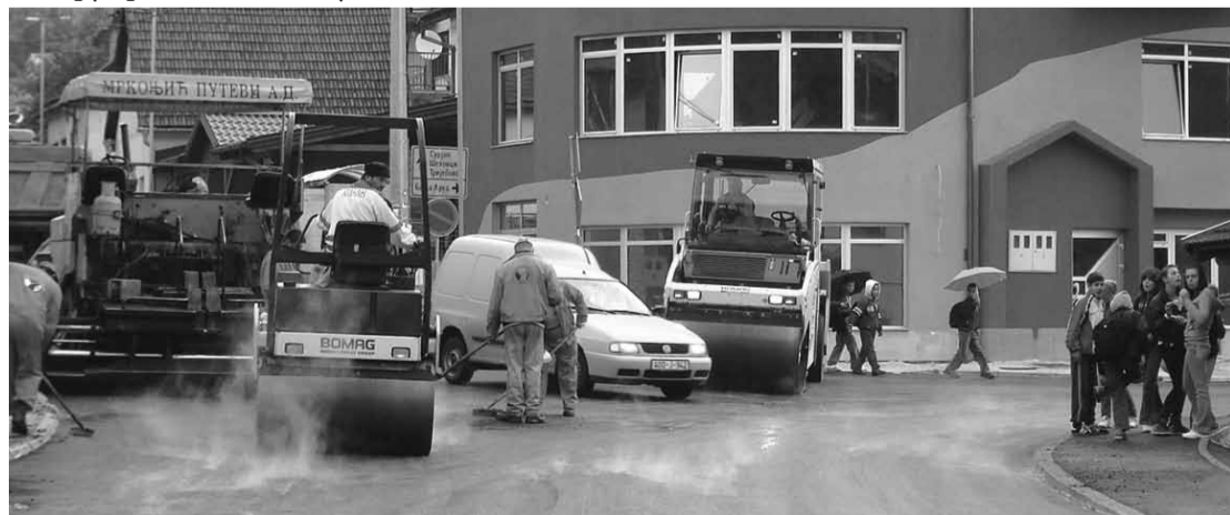
Асфалтирање улице Цара Душана
