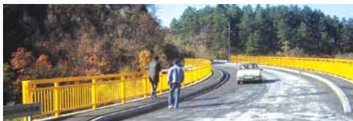
Обновљен мост на Црној Ријеци
